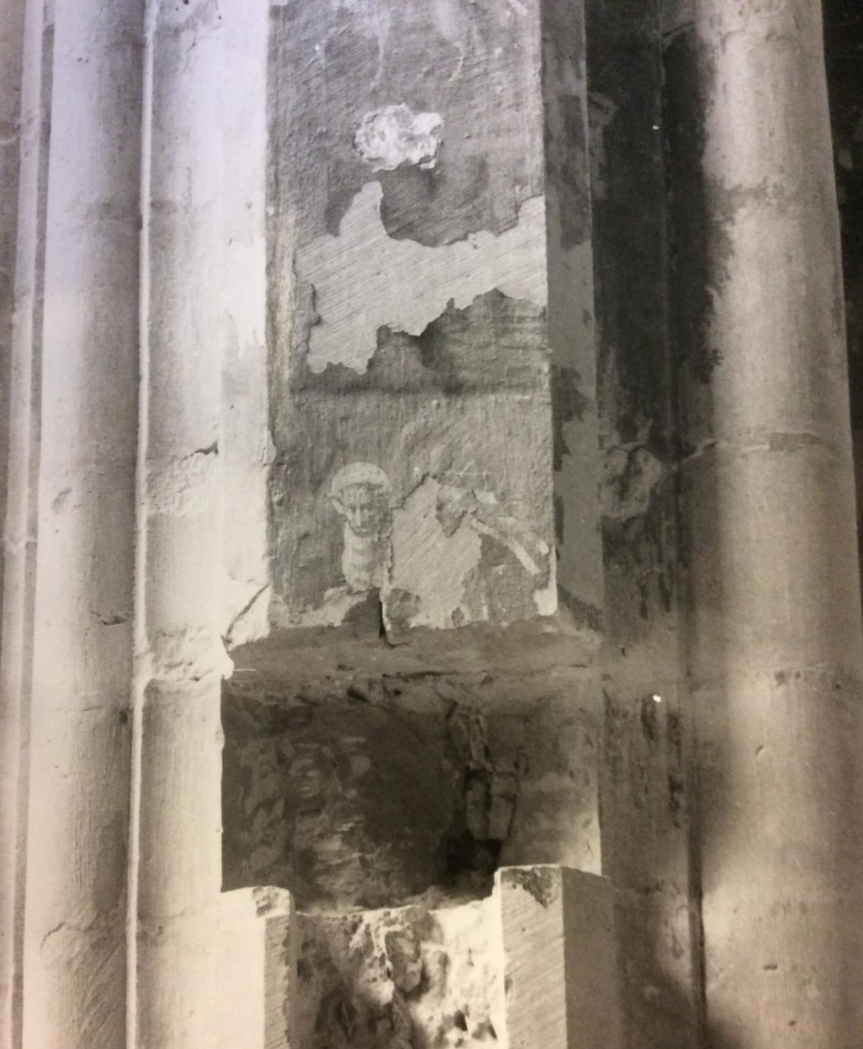
Fragmenten van een Lam-Godsmotief op de zijbeukpijlers na zandstralen. Foto APA, Archief Guido Derks
